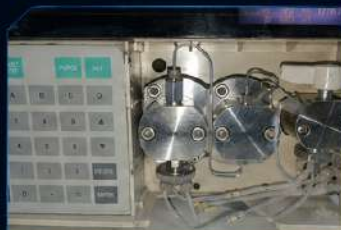
LIMPIEZA Y DESMONTAJE DE SISTEMAS DE BOMBEO
